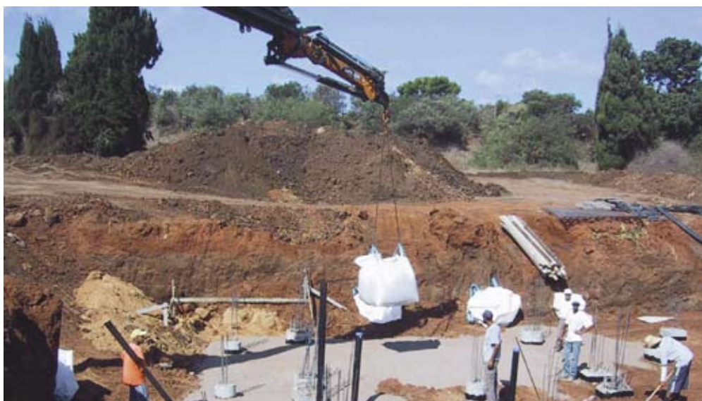
יצירת חיץ פיזי של חול "סילסנד" יגן על המבנה מפני חדירת טרמיטים. חב' נאוסיל
